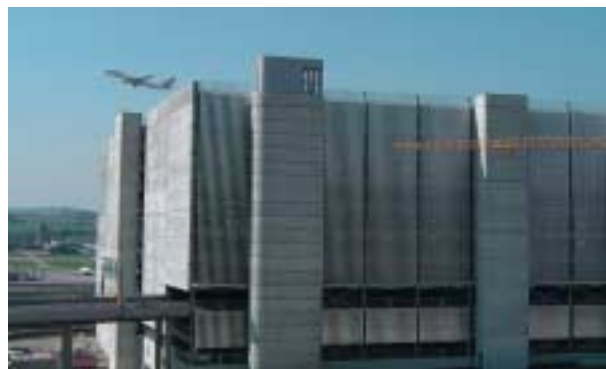
Parkhaus Kloten, Stahlkonstruktion, bis 20 m Länge, total 5'000t
