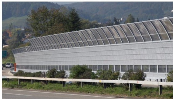
Wirksam, robust, langlebig und ästhetisch zugleich: mit Thermoplex-2-Verfahren beschichtete Lärmschutzwand an einer Schweizer Autobahn
