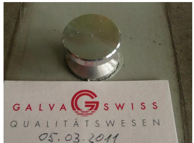
Haftzugprüfung an der Hängekonsole; die Prüfung wurde bei 35 kg cm 2 abgebrochen
