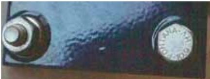
Aufwulstung durch Farbbeschichtung > 120 µm.
