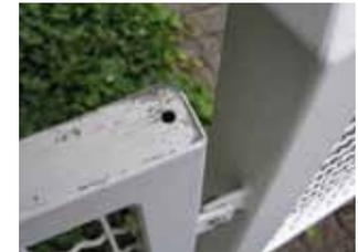
Durch mechanische Einwirkungen wurde der Lack stellenweise von der Zinkoberfläche abgetragen. Trotzdem wird der Lack kaum unterwandert und der Korrosionsschutz ist weiterhin gewährleistet.
