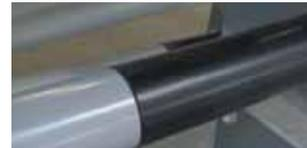
Kandelaber: Feuerverzinkt und beschichtet (Duplex). Im belasteten Bereich (Erdübergangsbereich inkl. Urin- und Kotbelastung durch Tiere, Streusalz etc.) ist eine Polyolefin-Folie (ca. 1 mm dick) aufgeschumpft.
