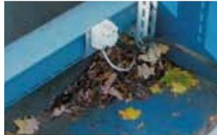
Grössere Mengen von Laub vermisch mit Schmutz bilden ein dauerfeuchtes Klima, welchem auf die Länge kein Korrosionsschutz widerstehen kann. Solche Ansammlungen müssen regelmässig entfernt werden – besenrein genügt.
