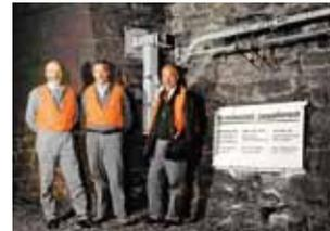
Start des Versuches im Simplontunnel im September 1992. An der Wand der Fahrleitungsausleger, an welchem auch 18 Jahre später, trotz starker Belastung im Tunnel, keinerlei Korrosion festgestellt wurde.
