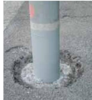
Sanierung Kandelaber: Freilegen des Kandelabers bis zum Fundament-Beton, Reinigen und Neubeschichten des Übergangsbereiches im Teer-Belag.
