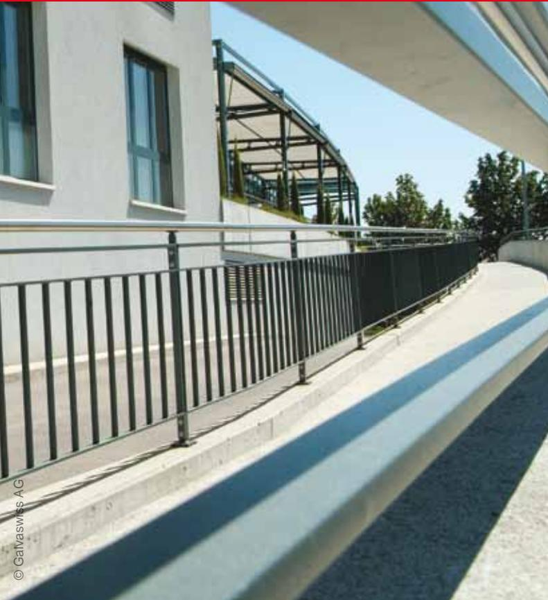
Das robuste Duplex-Verfahren Feuerverzinkung + Pulverlackierung in allen RAL-, NCS- und einigen mcs-Farben für eine Nutzungsdauer von über 45 Jahren
