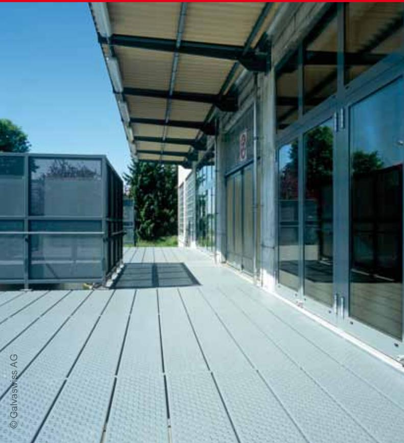
**Das hochwertige Duplex-Verfahren Feuerverzinkung + Nasslackierung in allen RAL-, NCS- und mcs-Farben für eine Nutzungsdauer von 45 Jahren und mehr**
