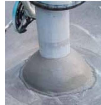
Reprofilieren mit Mörtel/Beton derart, dass Wasser gut abfließen kann: keine liegende Nässe im Übergangsbereich. Überlackieren im Bereich Stahlmast-Beton-Kappe.
