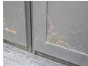
Die Beschichtung direkt auf den Stahl kann der erhöhten Feuchte und den vermehrten mechanischen Einwirkungen in Bodennähe nicht widerstehen. Der Lack wird unterwandert und durch den Rost abgesprengt.
